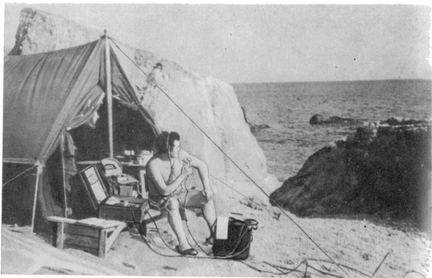
Разбив на берегу палатку, мы установили портативную акустическую аппаратуру и «забросили» гидрофоны в вольер с четырьмя дельфинами, расположенный в 60 м от берега. Послушаем теперь, о чём они «говорят»
